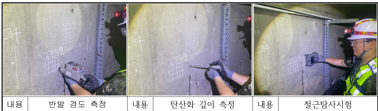
【사진 8.3】 금촌인출 전력구 재료시험 전경
